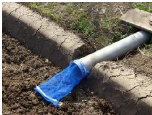
取水口への網の設置
