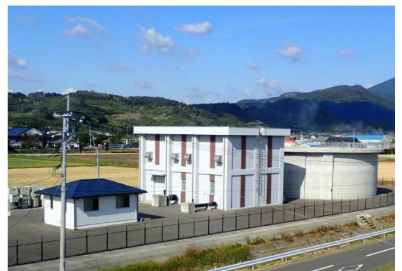
農業用水の安定確保(多久揚水機場)
