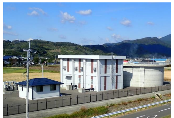
農業用水の安定確保(多久揚水機場)
