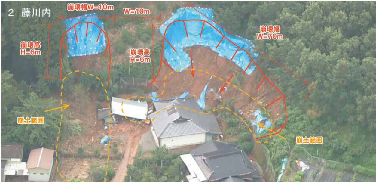
③ 藤川内の急傾斜地崩落
