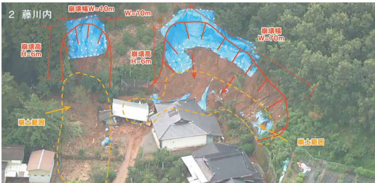
③ 藤川内の急傾斜地崩落
