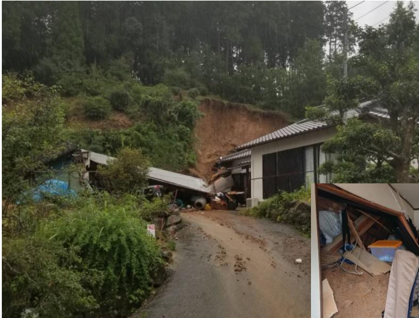
藤の川内地区土砂崩落
