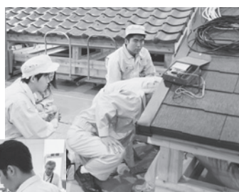
▲太陽光パネル設置の実習で、取り付けなどの説明を受ける生徒
