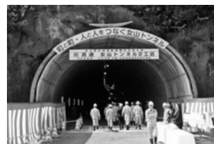
▲女山トンネル工事着手
