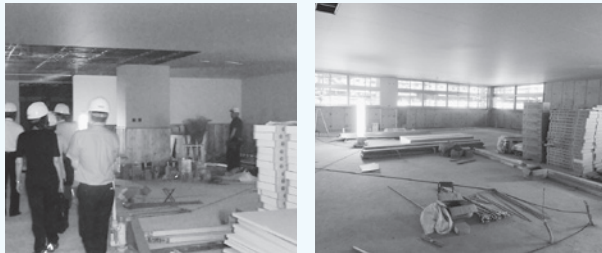
▲写真は、小中学校の先生が共に入る職員室の工事現場です。
