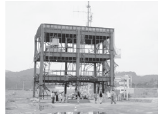
▶南三陸町防災センター
