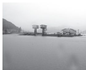
◀7月13日の北部九州豪雨で、市内でも東・南多久の一部地域に避難勧告を発令。床上・床下浸水や土砂災害など被害が発生しました。(写真上は氾濫危険水位を超えた牛津川の様子)
