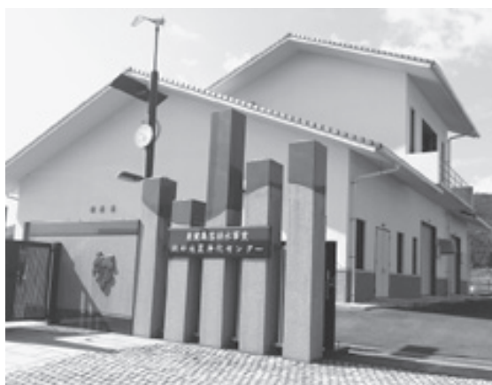
農業集落排水事業 納所地区浄化センター
