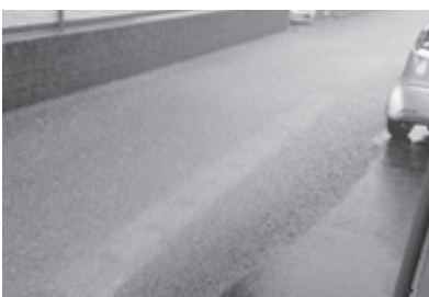
大雨で冠水した道路
