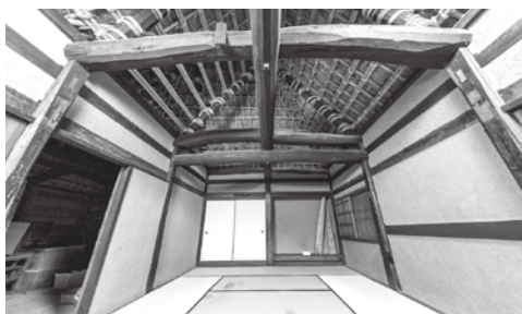
▶(住宅内部) ザシキと屋根小屋組
