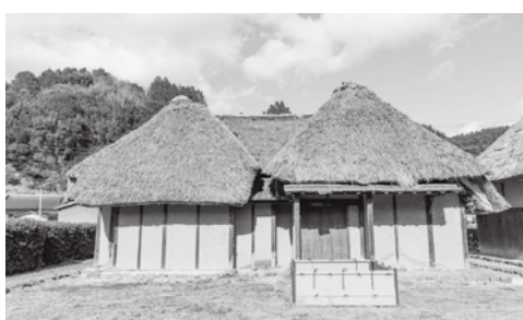
▶建物背面(裏) 側からみた川打家住宅
