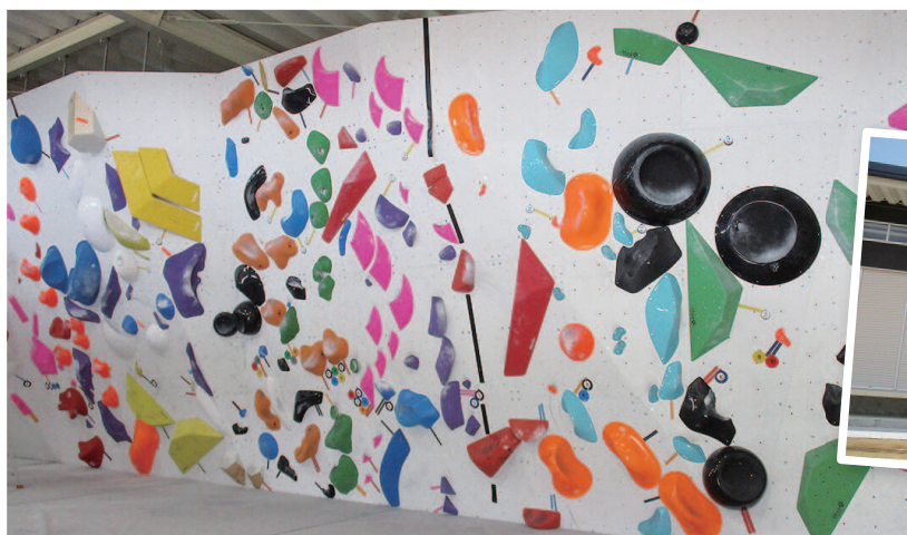
ボルダーウォール：幅 30.0m × 高さ 4.8m、最大傾斜 130 度
