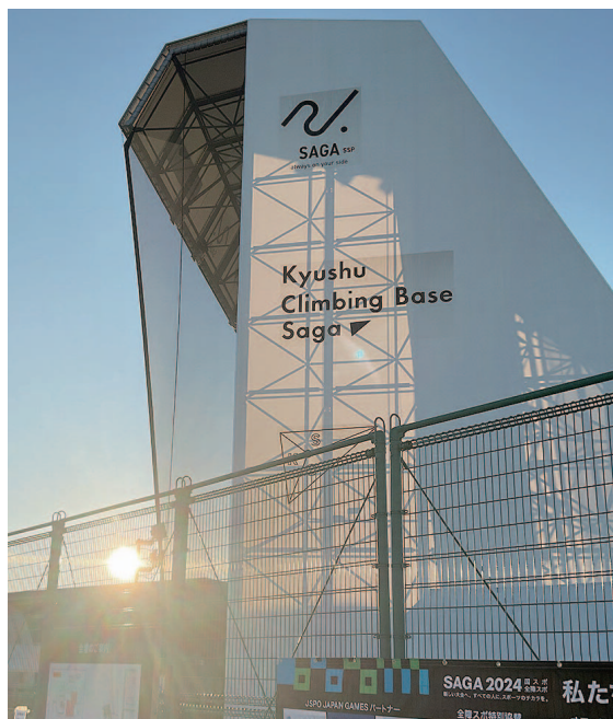
リードウォール：幅 12.0m × 高さ 15m、張出し 11m、最大傾斜 150 度
