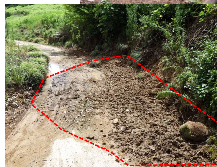
市道黒牟田2号線 (単独災害復旧事業) 崩土除去
