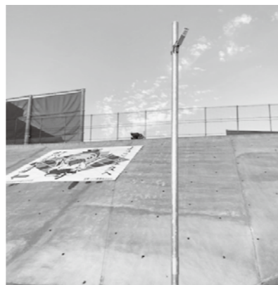
中央公園園路照明設備設置工事
