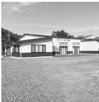
北多久公民館建設工事
