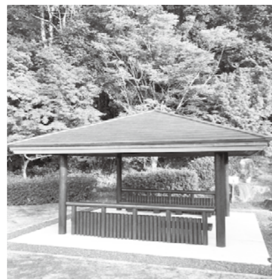
中央公園休養施設改修工事
