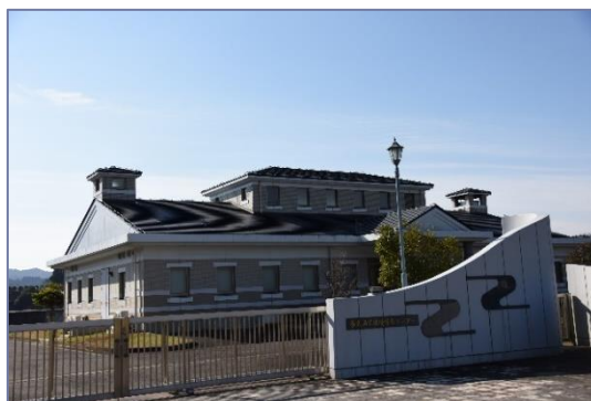
多久みず環境保全センター
