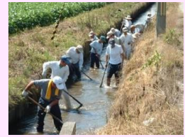
水路の泥上げ
