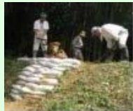
漏水箇所の補修
