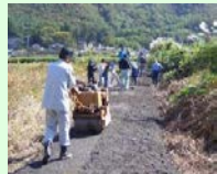
未舗装農道の舗装
