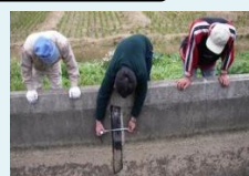
施設の機能診断
