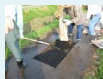
農道の部分補修
