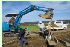
コンクリート水路の更新
