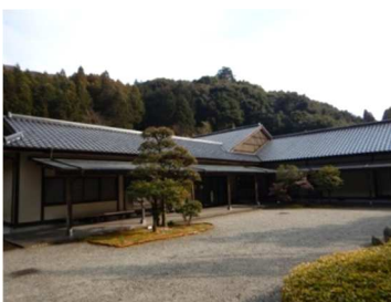
写真 5-30 東原庵舎（宿泊研修施設）
