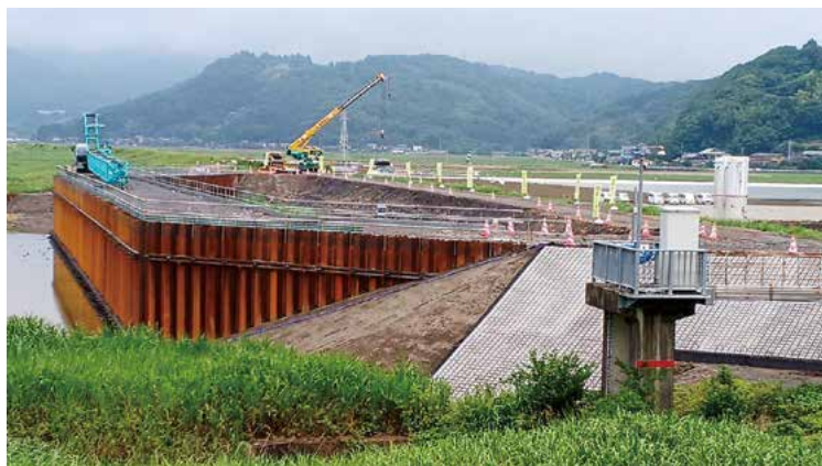
小城市に建設中の遊水地
