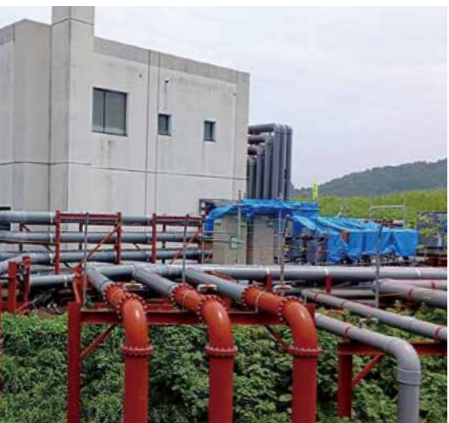
納所排水機場
