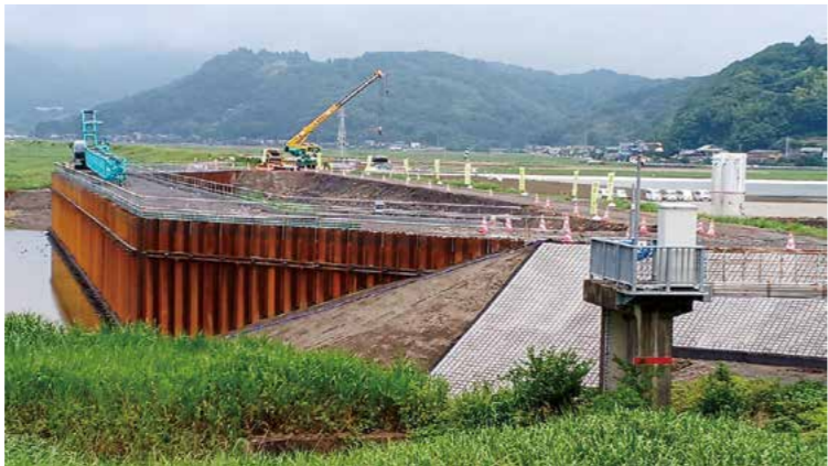
小城市に建設中の遊水地
