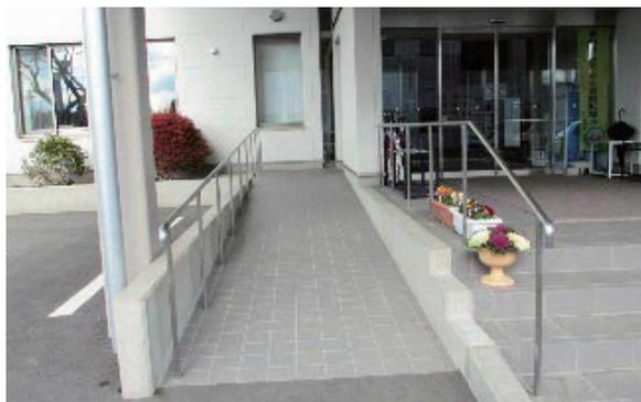
写真：出入口の段差解消
