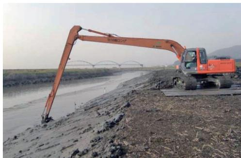
写真：河道掘削状況(牛津川)
