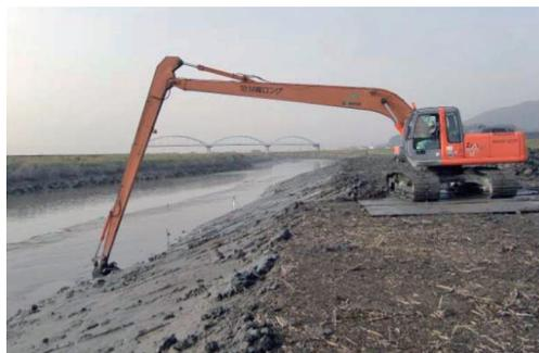
写真：河道掘削状況(牛津川)
