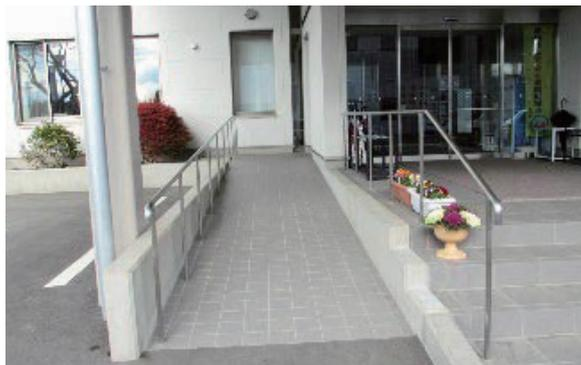
写真：出入口の段差解消
