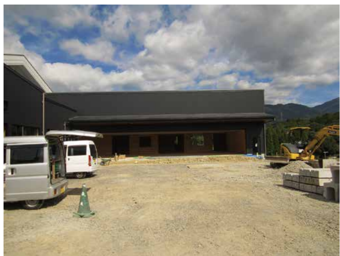
弓道場建設工事
