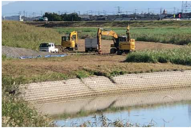
牛津川浚渫工事
