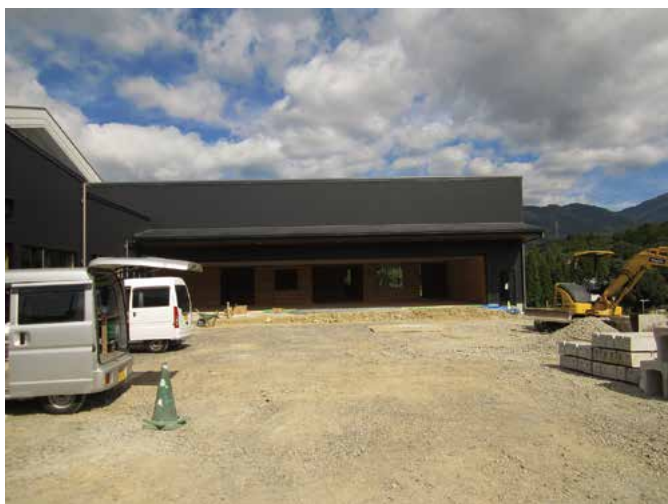
弓道場建設工事
