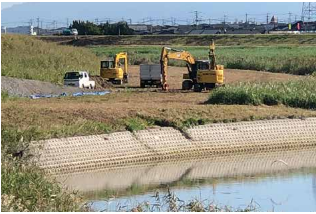
牛津川浚渫工事
