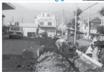
▲ 昭和40年代の 水道管理設工事
