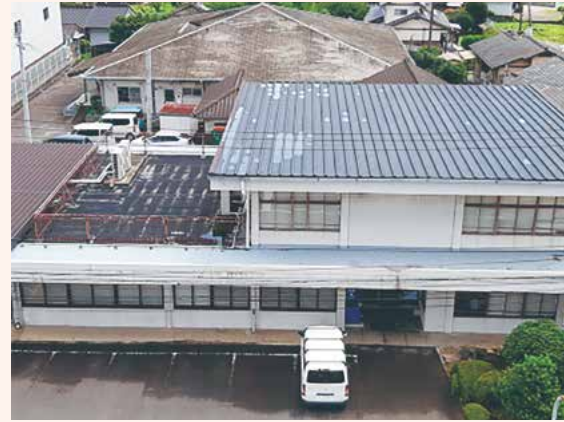
築54年の多久市役所 東庁舎
